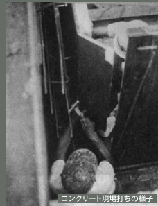
コンクリート現場打ちの様子
