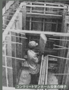
コンクリートマンホール設置の様子
