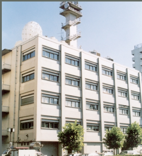
TRC局舎全景
