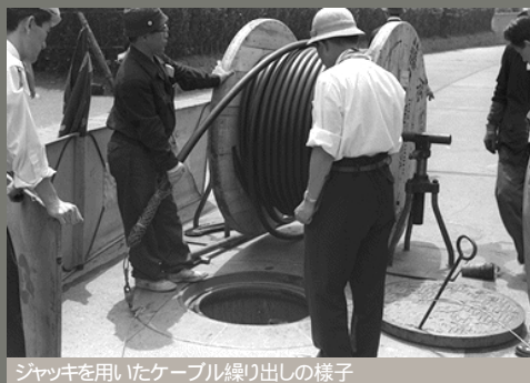
ジャッキを用いたケーブル繰り出しの様子
