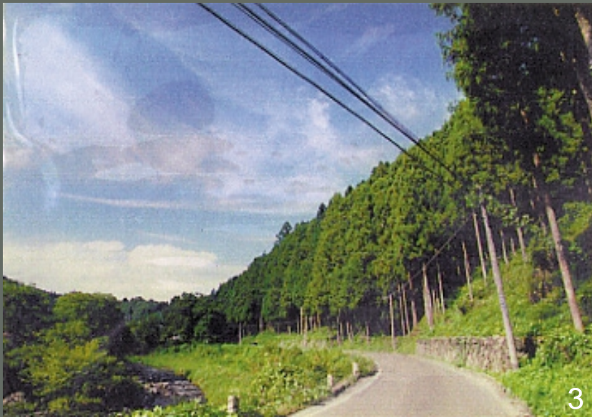
1. 腐食:海岸沿いの通信設備
