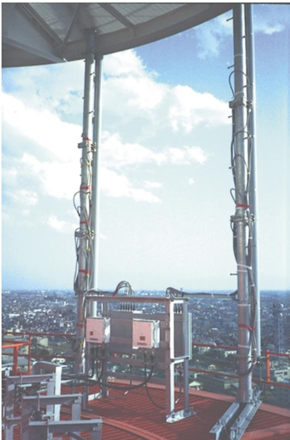
ここに展示されているオムニゾーン基地局用アンテナは、水平面内のビーム幅を反射板間の角度を変えることにより可変としている。また、一般的に基地局のアンテナは、建造物の屋上に設置されていることが多く、基地局の送受信装置と離れているため、受信した電波が同軸ケーブルを伝わる間に減衰してしまう。そこでアンテナ直下に屋外受信増幅器(写真中の2つの白い箱)を設置し、アンテナで受信した電波を増幅する構成としている。
